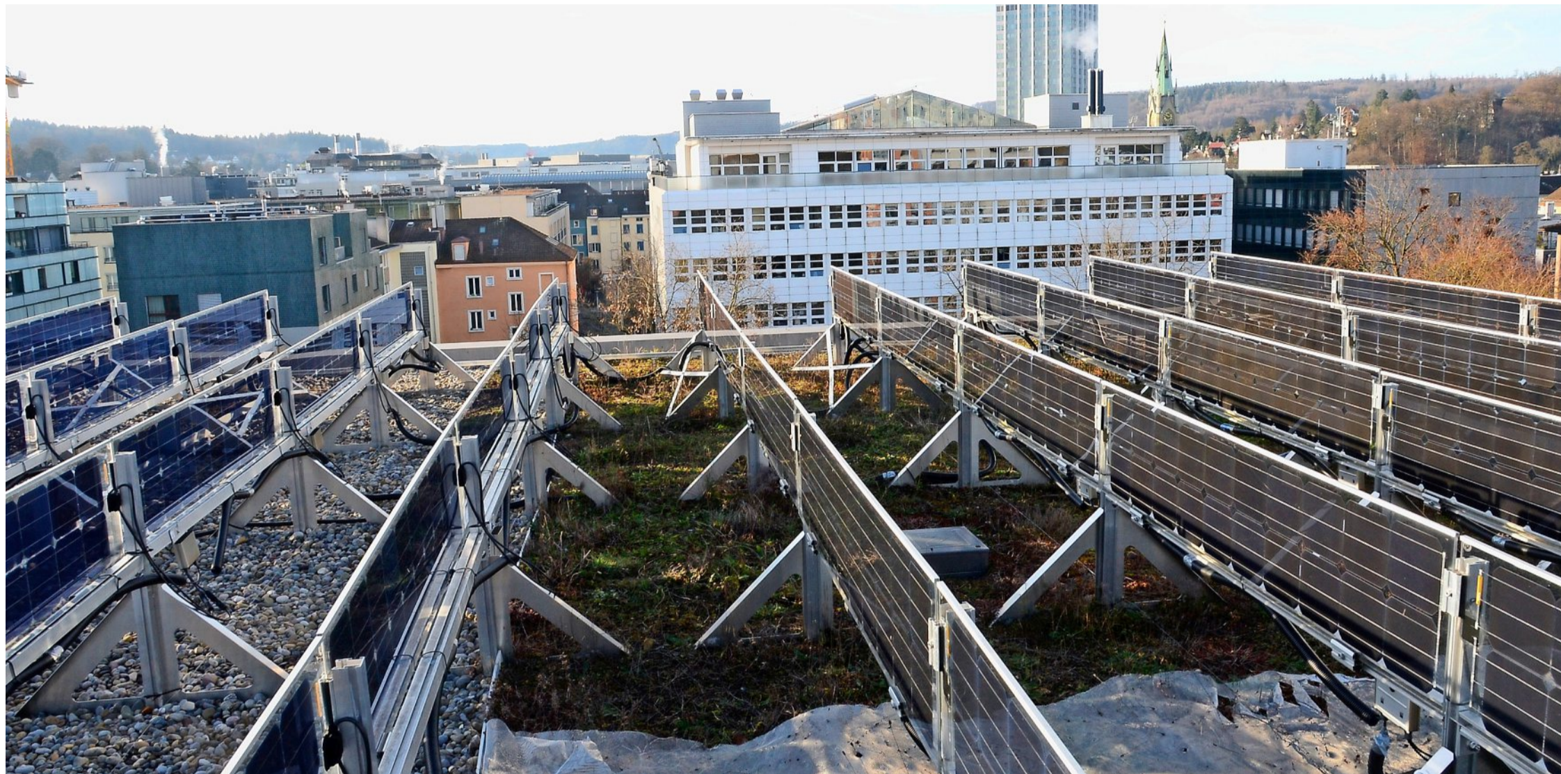
Wer Silberlaub sät, erntet mehr Strom. Die Pflanzen, die auf dem Wiesengrund wachsen, reflektieren unterschiedlich viel Licht auf die Solarmodule. Foto: Marc Dahinden
