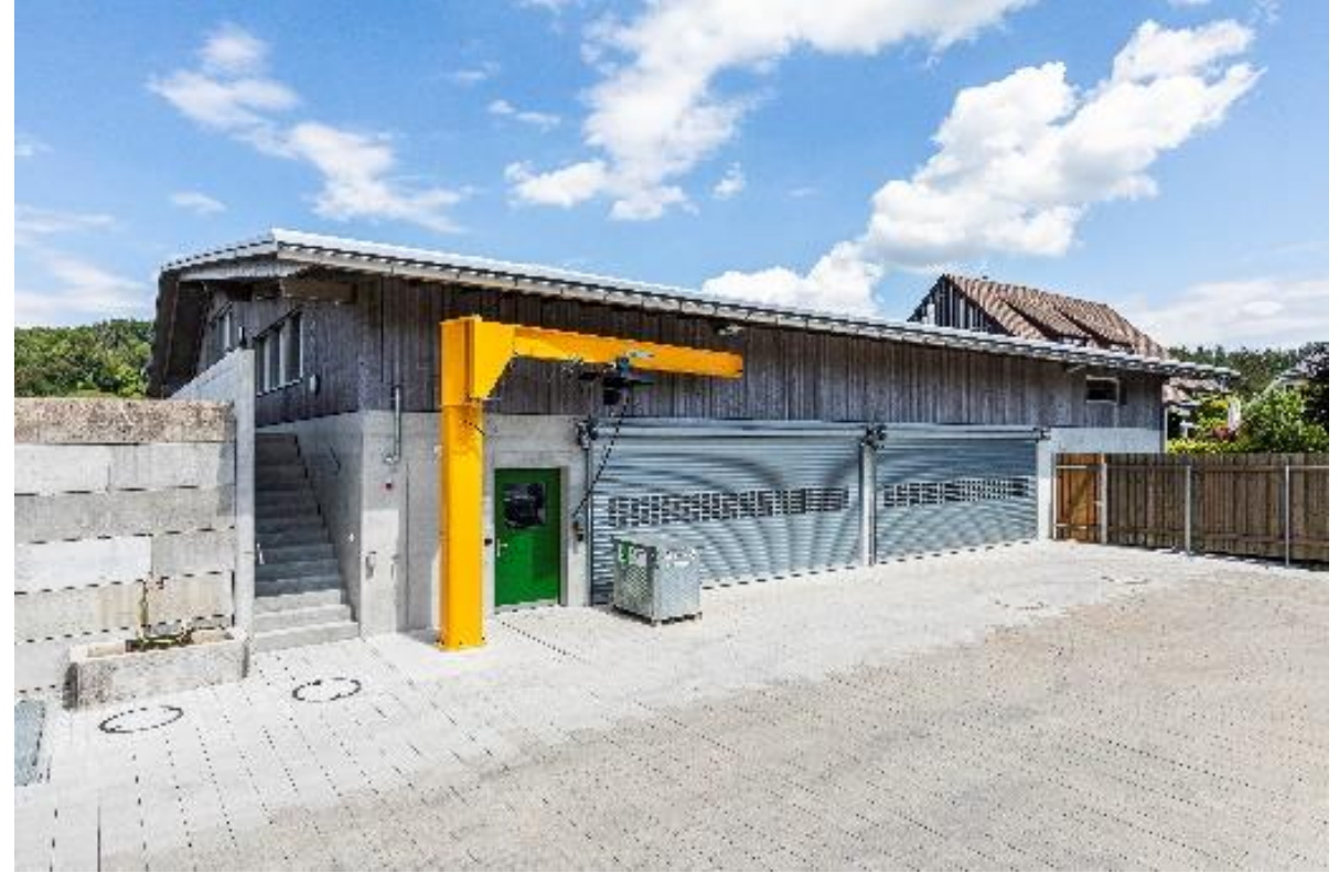
Rückseite: Lagerräume und Tiefgarage
