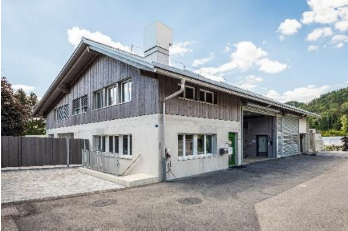
Bürotrakt, Aufenthaltsraum, Werkstatt, Waschplätze
