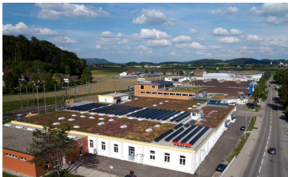
Betriebsgebäude SOLTOP in Elgg
